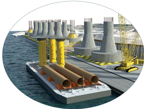
Algunos componentes fabricados se transportarán a flote por el río Hudson hasta un predio de montaje para realizar el ensamblaje final antes de la instalación.
